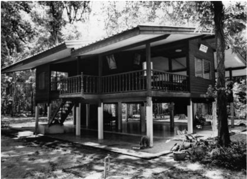
Kuti de Luang Por Chah 1964-1981 (la fotografía fue tomada luego de una renovación).
